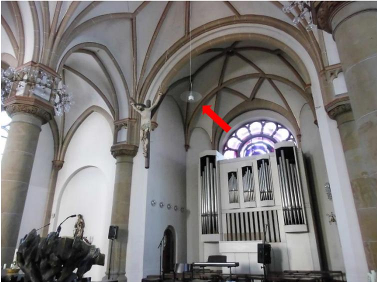
*Abbildung 7: Mini-Lautsprechersystem in der vorgesehenen Position (Satellitenanordnung). Hier Lautsprechersystem 1 hinter dem Altarbereich. Die Lautsprechergröße und auch der Reflektor werden als unauffällig empfunden.*
