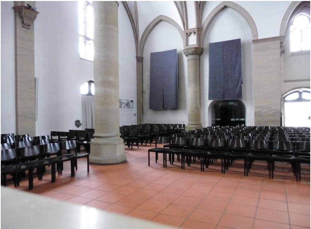
*Abbildung 3: Provisorisch aufgehängte Schallabsorber zur Unterdrückung ungünstiger Schall-Laufzeitdifferenzen an der Kirchenrückwand vom Altar aus gesehen.*
